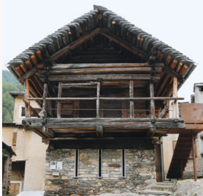
Äußerlich alt, innen topmodern: ein traditionelles Tessiner Rustico, restauriert von Giovan Luigi Dazio
