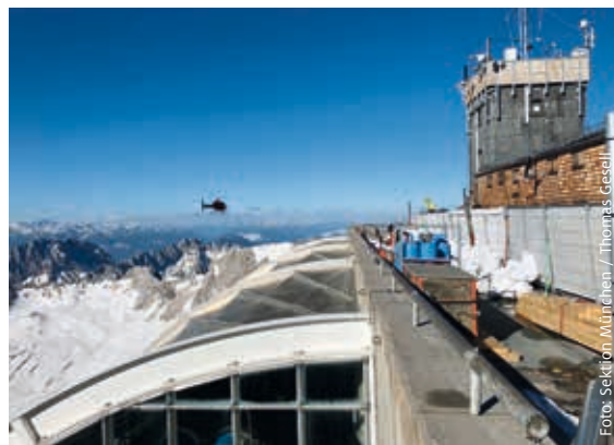
↑ Terrassenarbeiten auf dem Münchner Haus auf der Zugspitze
